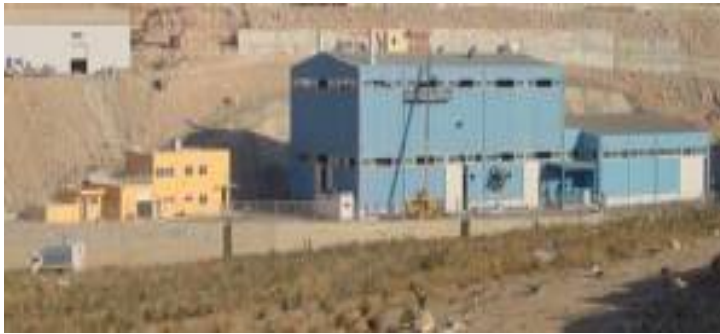
Σχήμα 14.3: Μονάδα αποτέφρωσης απορριμμάτων στην περιοχή Α. Λιοσίων Αττικής
