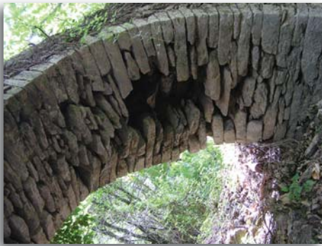
Εικ.36. Αγ. Λαυρέντιος, υδατογέφυρα Χατζήγη.
