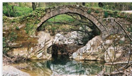
Εικ.35. Νεοχώρι, βυθισμένο σε τεχνητή λίμνη.
