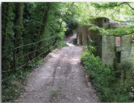
Εικ.38. Δράκεια, το μεγαλύτερο μονότοξο, πλάι στο λιοτρίβι του Μίχου.
