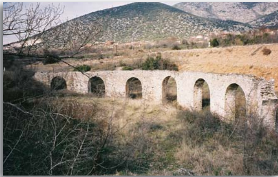
Εικ.09. Υδατογέφυρα στο Νικηφόρο Ξάνθης.
