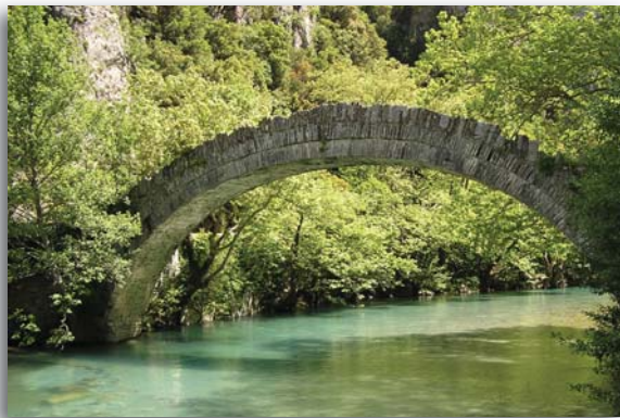
Εικ.07. Γεφύρι Κλειδωνιάς στο Βοϊδομάτη.
