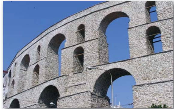
Εικ.10. Υδατογέφυρα στην Καβάλα.
