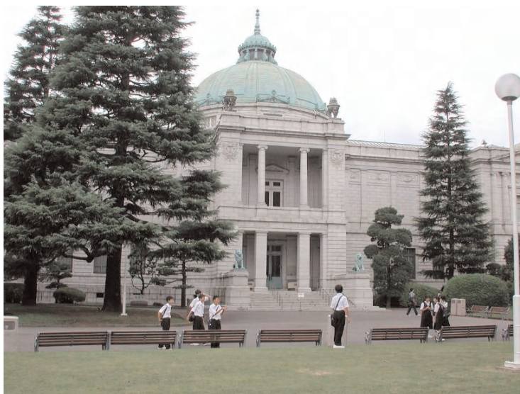
Εξωτερική όψη του Εθνικού Μουσείου του Τόκιο ( http://www.carto.net/neumann/travelling/japan_2004_09/09_tokyo_2004_09_24-25/11_tokyo_national_museum_hyokeikan_building.jpg )
