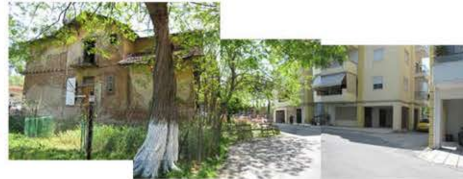
5 οδός Αφροδίτης - ασυνέχεια οδικού δικτύου
