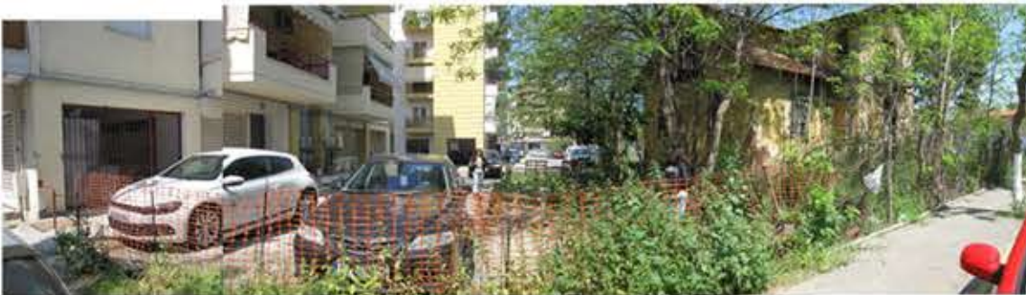
4 οδός Αφροδίτης - ασυνέχεια οδικού δικτύου
