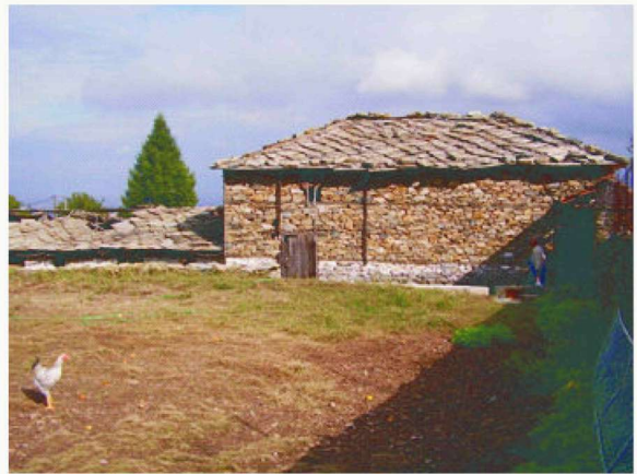
Εικόνα 18. Βοηθητικά κτίσματα στην αυλή. Αρχείο Κ.Π.Ε. Φιλίππων.
