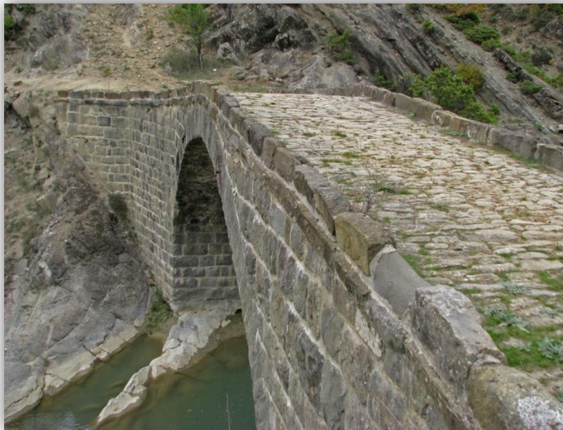
Εικόνα 27: Γεφύρι στο Νιδρούζι, Πηγή: Κ.Π.Ε. Γρεβενών
