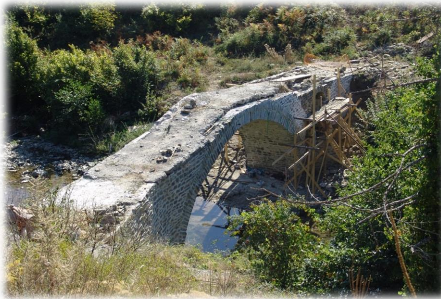
Εικόνα 55: Γεφύρι του Σταμπέκη (μετά την αποκατάσταση) 2006, Πηγή: ΚΠΕ Γρεβενών
