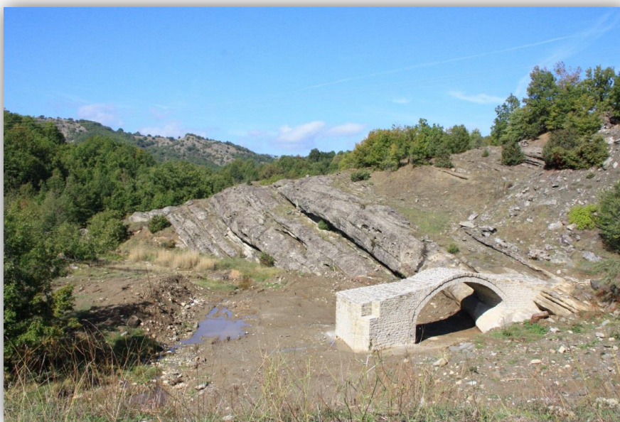
Εικόνα 63:Εργασίες επισκευής στο Γεφύρι Κυπαρισσίου (Παπατάκη) 2012, Φώτο: ΚΠΕ Γρεβενών
