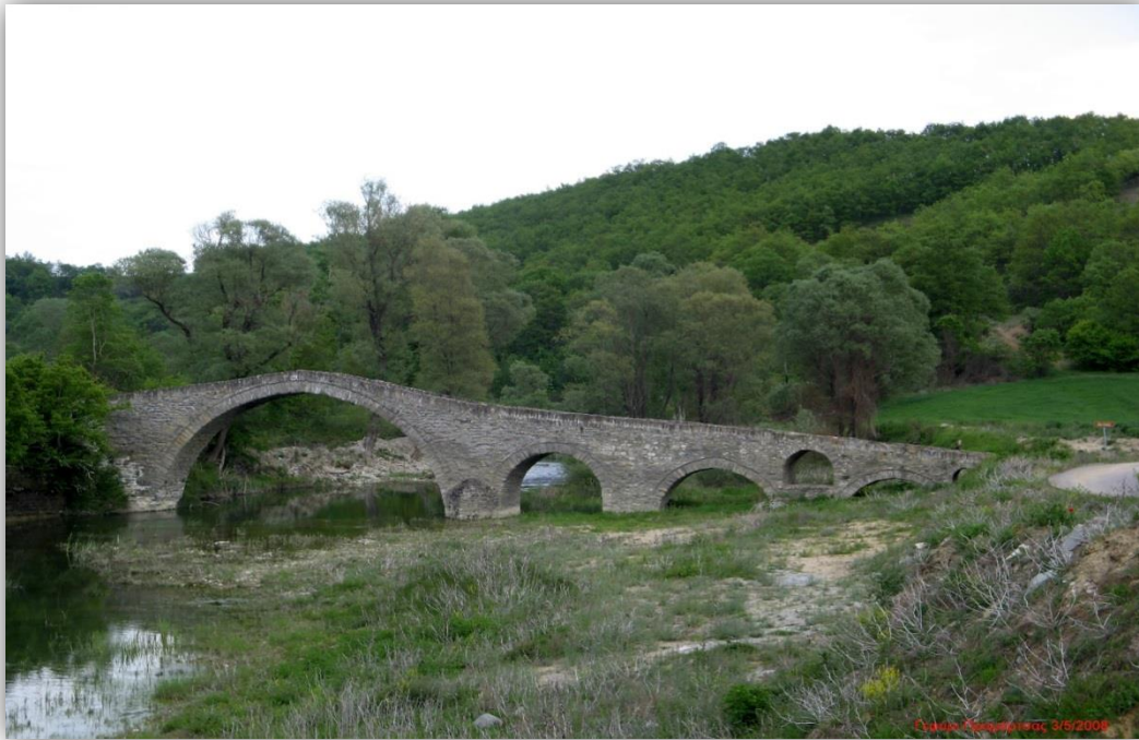
Εικόνα 61: Γεφύρι Πραμόριτσας, Πηγή: Ευάγγελος Επισκόπου (2008)
