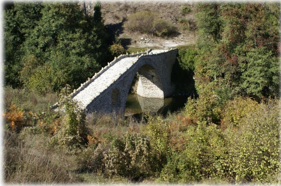
Εικόνα 54: Γεφύρι του Σταμπέκη (εργασίες αποκατάστασης) 2006, Πηγή: ΚΠΕ Γρεβενών
