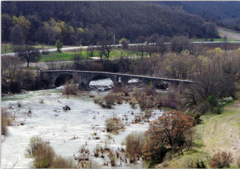
Εικόνα 51: Γεφύρι Σπανού – Πηγή: Κ.Π.Ε. Γρεβενών
