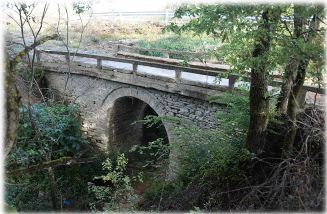
Εικόνα 70: Γεφύρι του Παπά ή Τζινέλι στο (Κληματάκι Γρεβενών), Πηγή: Κ.Π.Ε. Γρεβενών (2013)
