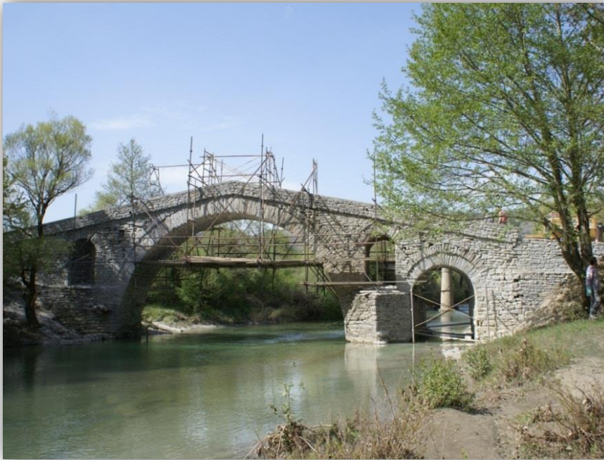
Εικόνα 31: Εργασίες ανακατασκευής του Γεφυριού στο Ζιάκα, Πηγή: Κ.Π.Ε. Γρεβενών
