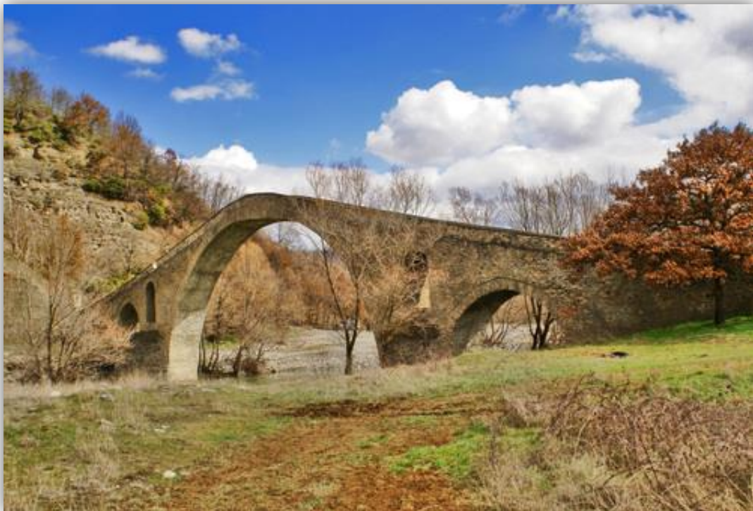
Εικόνα 45: Γεφύρι Αζίζ-Αγά – Πηγή: Κ.Π.Ε. Γρεβενών
