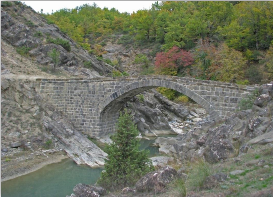
Εικόνα 26: Γεφύρι στο Νιδρούζι, Πηγή: Κ.Π.Ε. Γρεβενών
