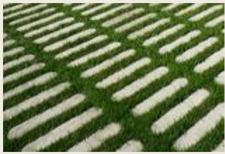
Δάπεδο από διάτρητο κυβόλιθο
