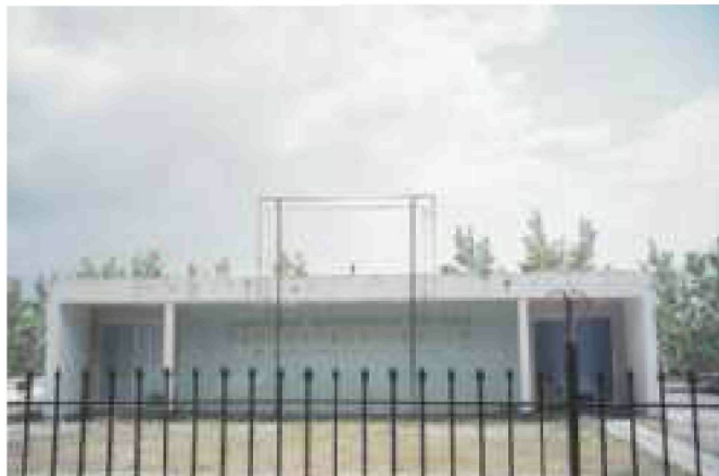
Εικόνα 10 Εξωτερική άποψη του κτιρίου των Λουτρών
