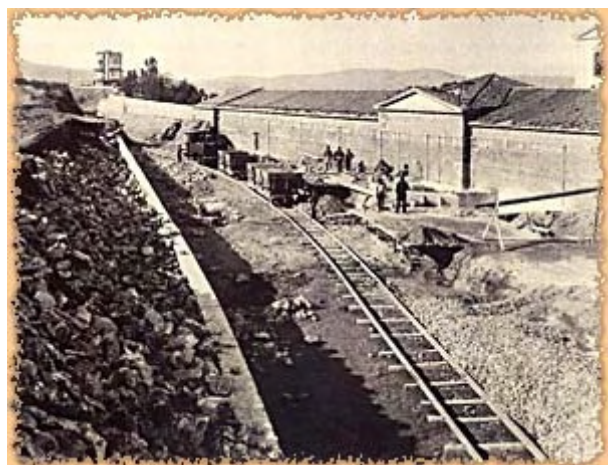
Κατασκευή σιδηροδρομικής γραμμής Πειραιά-Αθήνα, το 1890. ΗΣΑΠ. www.fhw.gr
