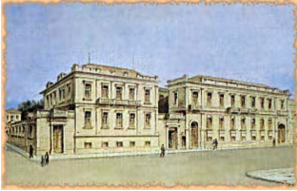
Το κτίριο της Εθνικής Τράπεζας στην οδό Αιόλου στην Αθήνα. Ιδρύθηκε το 1841. πάνω δεξιά: τα εγκαίνια της διώρυγας της Κορίνθου. www.fhw.gr
