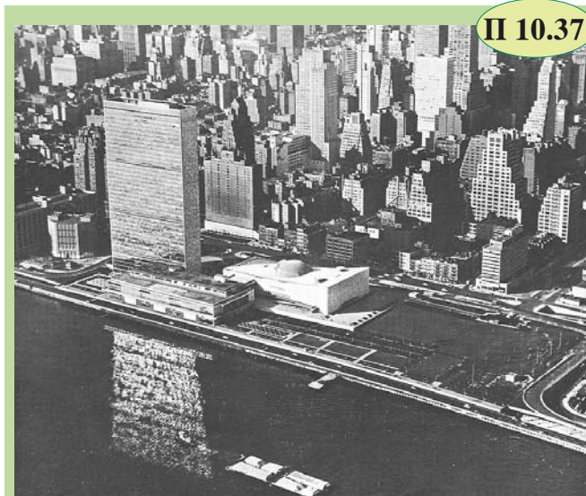
Το κτίριο του ΟΗΕ στη Νέα Υόρκη στις ΗΠΑ.
