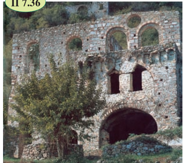
Η «Οικία Λάσκαρη» στο Μυστρά (Πελοπόννησος, Νομός Λακωνίας). Τα ερείπια στο Μυστρά δείχνουν πώς ήταν χτισμένα τα σπίτια των αριστοκρατών: στο ισόγειο ήταν οι βοηθητικοί χώροι και στους ορόφους ζούσαν οι ιδιοκτήτες του σπιτιού. Πολλά σπίτια είχαν στον πρώτο όροφο μπαλκόνια. 14ος – 15ος αιώνας.
