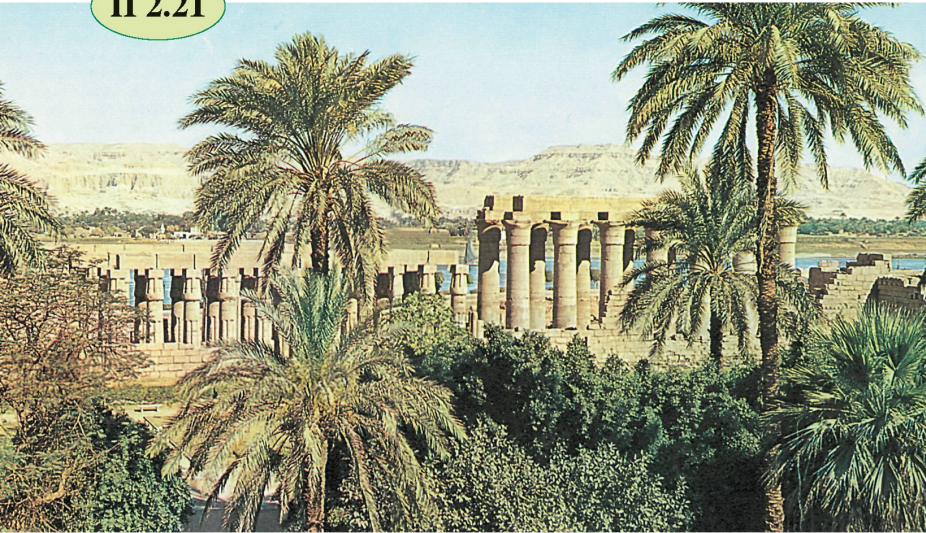
Ο ναός του Άμμωνα στις Θήβες στην Άνω Αίγυπτο (σημερινό Λούξορ), 2η χιλιετία π.Χ.
