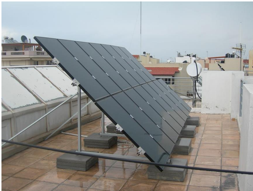
Εικ. 1. Σύστημα σταθερής στήριξης με μεταλλική κατασκευή.
