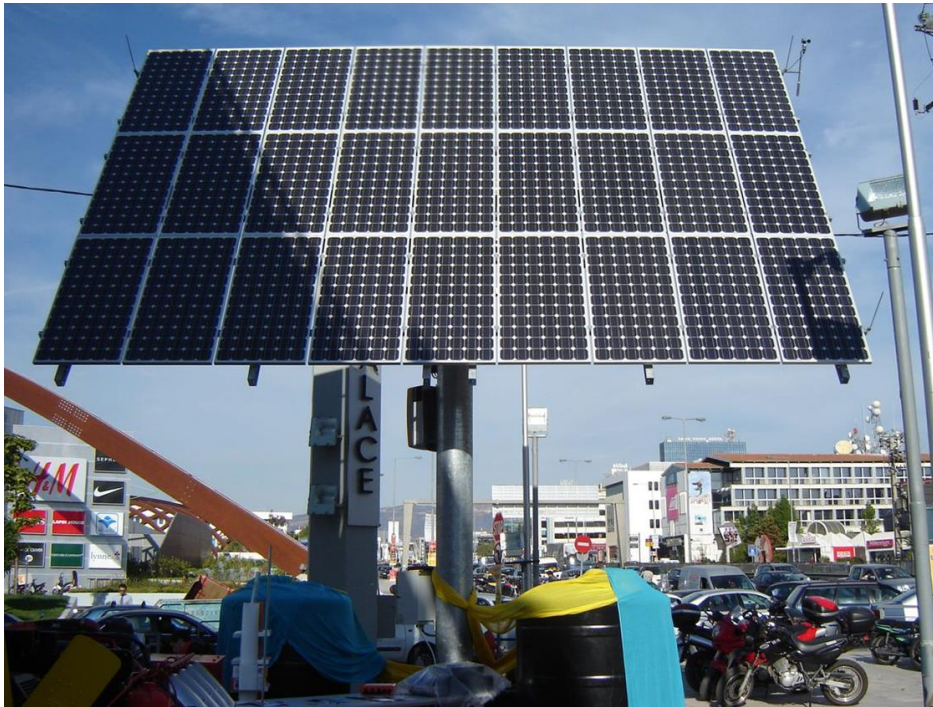
Εικ. 4: Εμπορικός ιχνηλάτης δύο αξόνων με σύστημα ελέγχου και αντικεραυνική προστασία.
