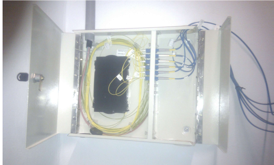
Εικόνα 5. Rack τερματισμού οπτικής ίνας και CPE 1 ου Γυμνασίου Ερμούπολης
