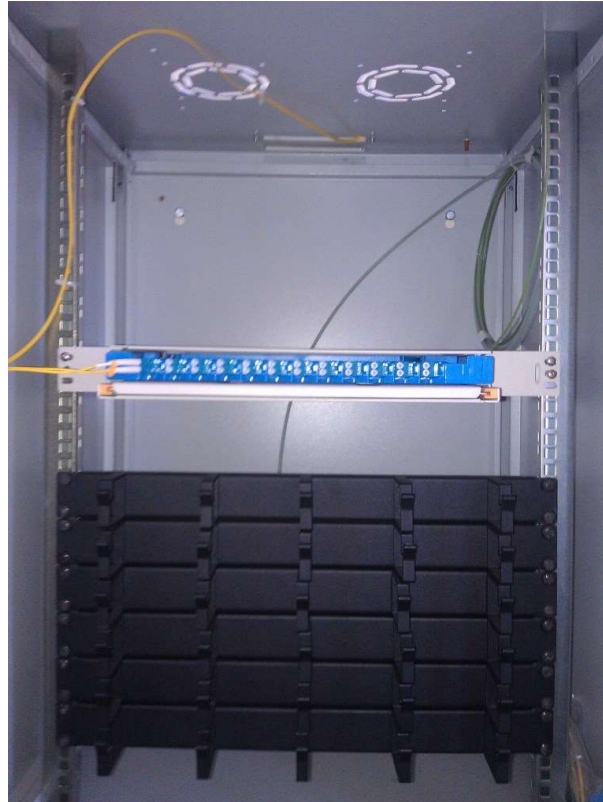
Εικόνα 6. Rack τερματισμού οπτικής ίνας και CPE 2 ου ΣΕΚ Ρόδου
