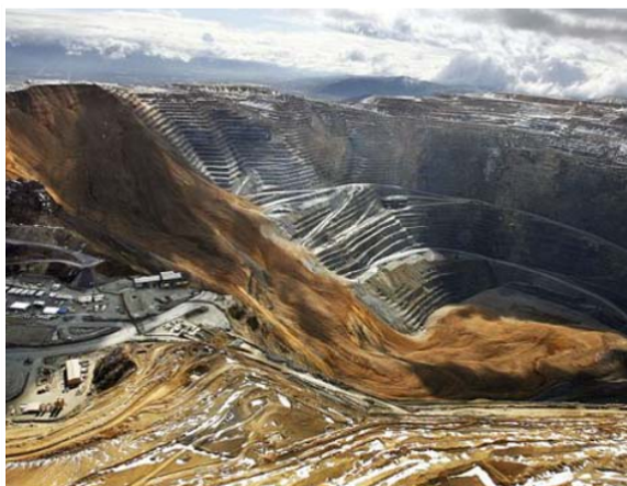
Εικόνα 7: Κατολίσθηση στη Β. Αμερική, 2013 πηγή: http://goo.gl/g5rjgP
