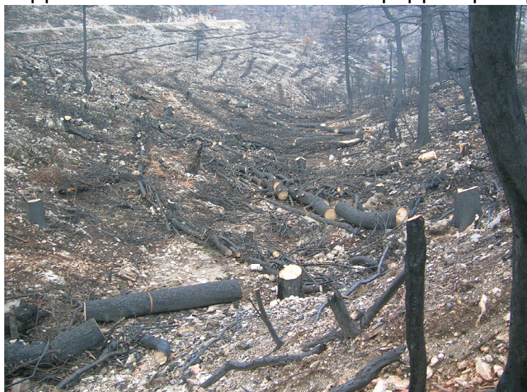
Κατασκευή κορμοπλεγμάτων μετά τη φωτιά της Πάρνηθας, καλοκαίρι 2007. Φωτ. Π. Πήλιουρας.
