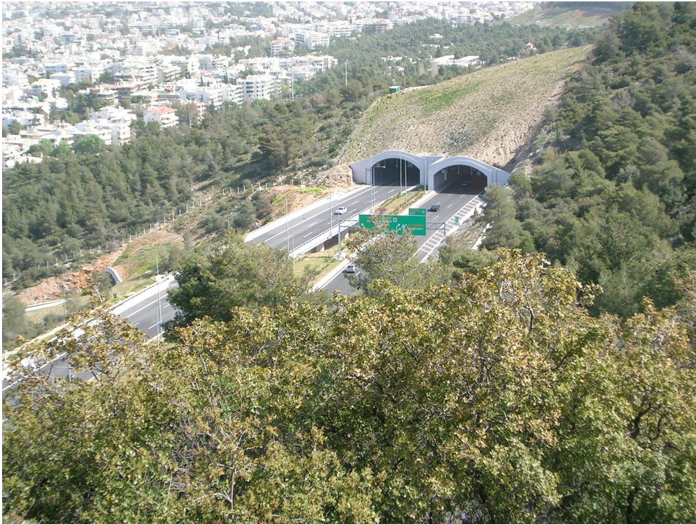
Κατασκευάζοντας σήραγγες εξασφαλίζουμε την «επικοινωνία» των δυο περιοχών του δάσους που χώρισε ο δρόμος. Φωτ. Π. Πήλιουρας.
