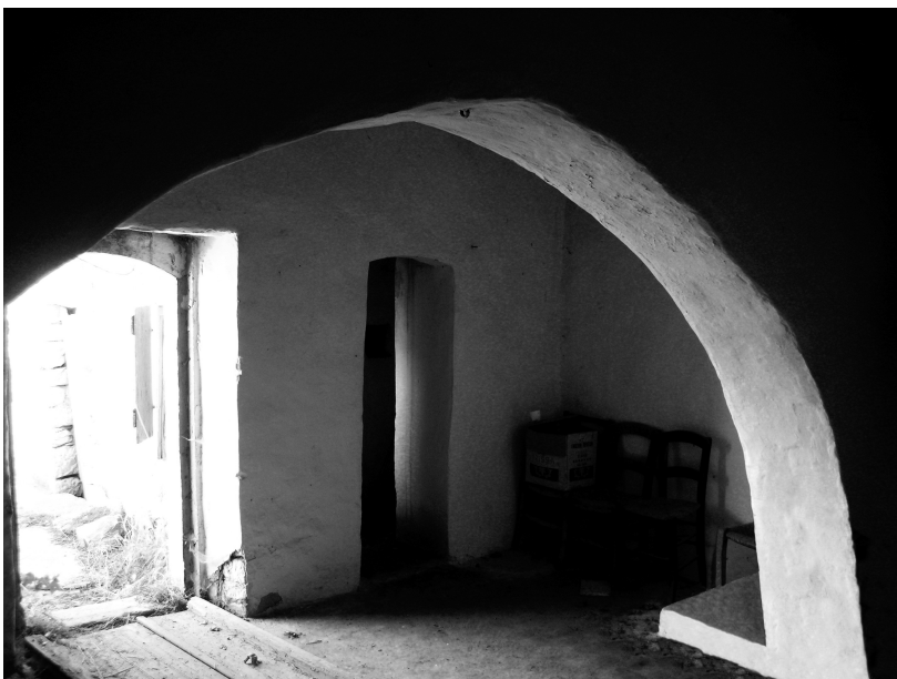
Καμάρα και πόρτεγο μονόχρωρου σπιτιού
